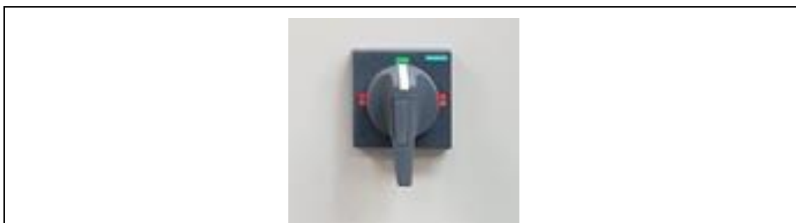
Fig. 4-3: Bryter for kontrollkabinettvelger
