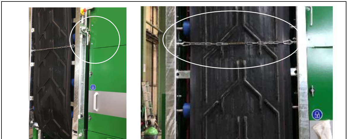
Fig. 7-3: Sikring av transport av 2.fraksjonen
