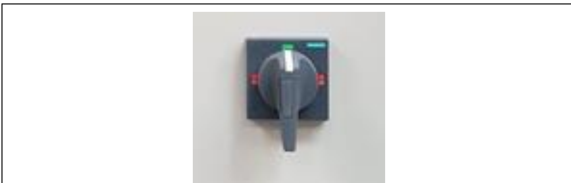
Fig. 4-3: Armario de distribución interruptor selector
