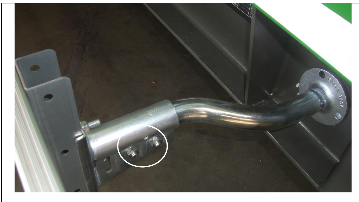
Fig. 7-10: Detalle del dispositivo de protección lateral
