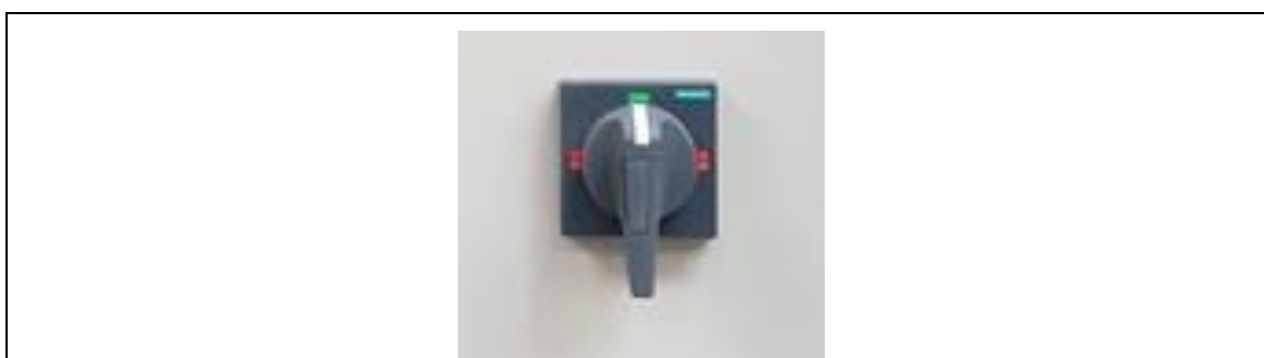
Sl. 4-3: Schaltschrank Auswahlswitch
