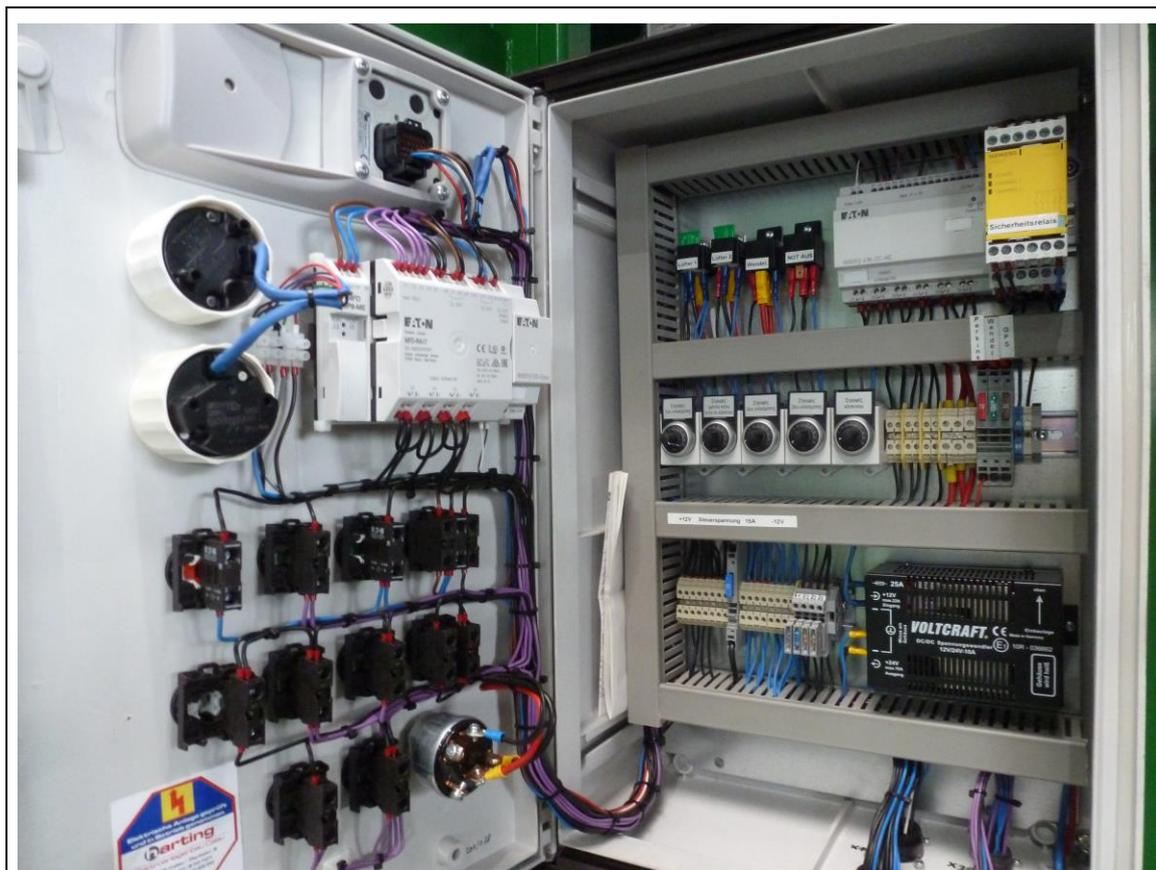
**Fig. 8-8: Unità di comando nel quadro elettrico ad armadio**
